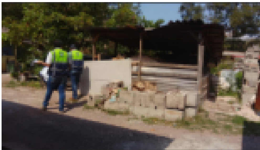
Foto No. 4 Remoción de materiales de construcción almacenados.
