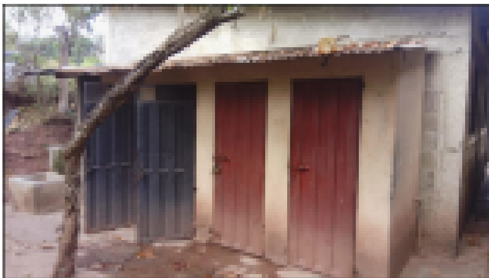
Foto No. 10 Demolición de paredes de bloque de concreto y desmontaje de puertas metálicas.
