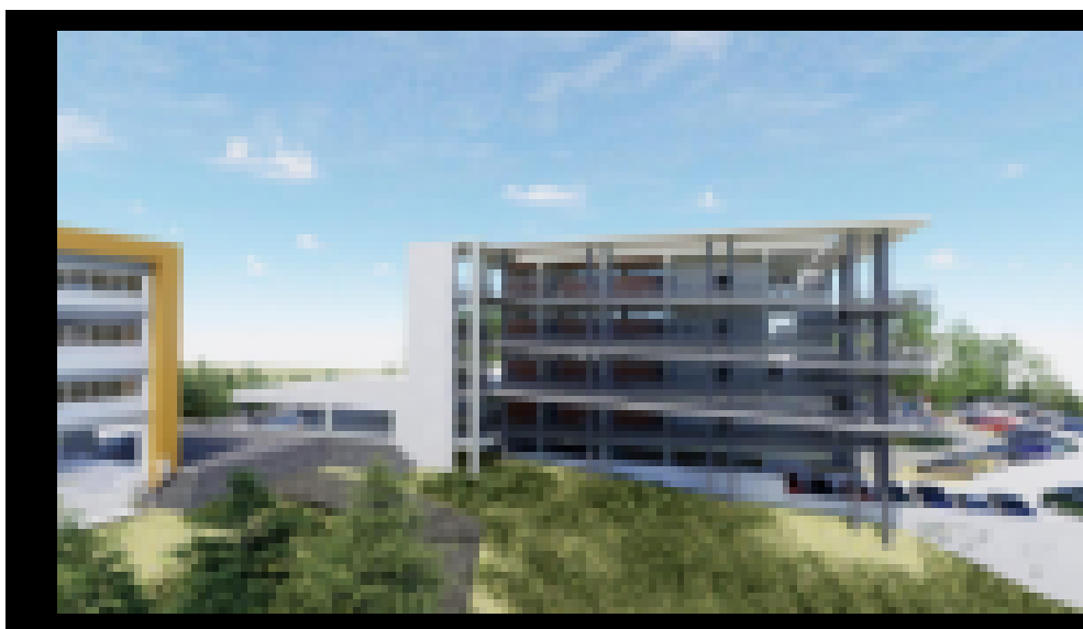
Imagen No. 1 Vista Noreste Edificio B3, Ciudad Universitaria.
