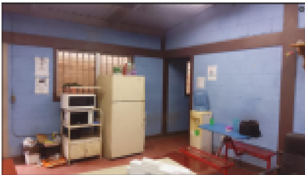
Foto No. 9-a Demolición de paredes de bloque de concreto, elementos de concreto (castillos, soleras). En sección de albañilería.
