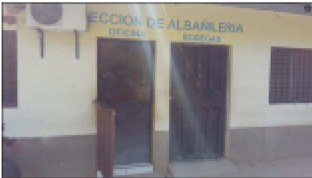
Foto No. 8 Demolición de paredes de bloque de concreto. En sección de albañilería.
